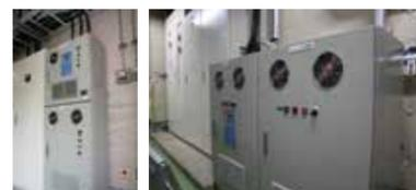
これがe・エネテックサーバー本体。冷却水・冷温水ポンプ用に2台、メインアリーナの空調機用に2台、計4台の設備が導入されている
